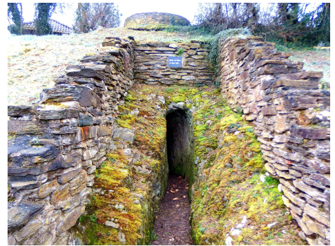
Die römische Wasserleitung in Pölich
