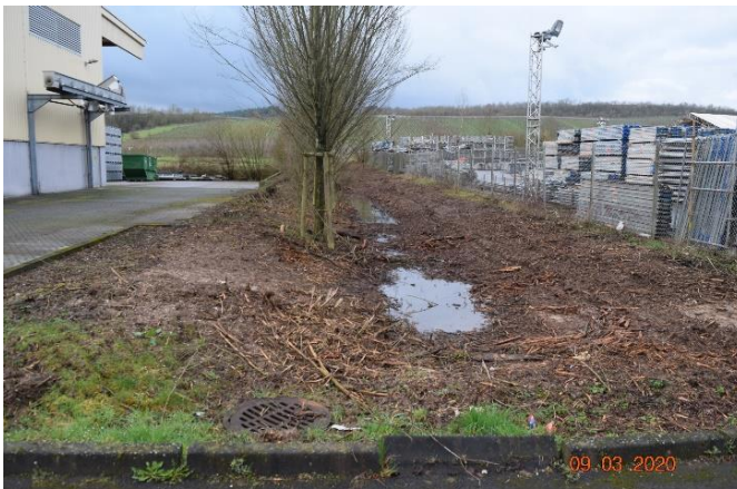
Entwässerungsmulde an der Moselland Winzergenossenschaft
