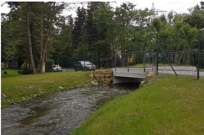
Brücke an der Longuicher Mühle nach Renaturierung
