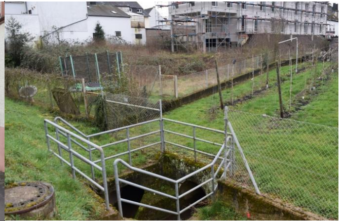
Offene Bachverrohrung vor Querung der Moselbahnstraße
