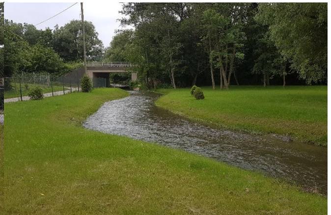
Brückenbauwerk der L 145 über den Feller Bach
