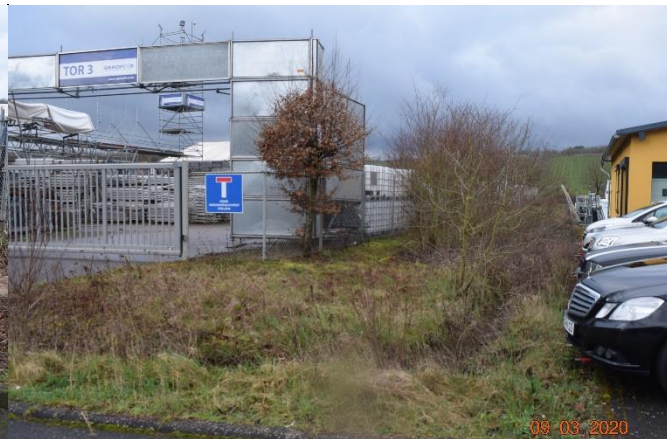
Entwässerungsmulde im Bereich Im Paesch 15 (rechts)
