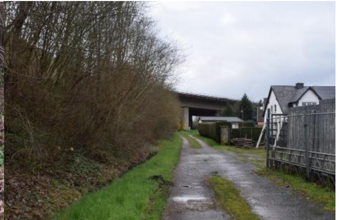
Zulaufgraben zum Einlassbauwerk
